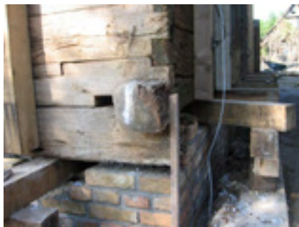
Podzidavanje nadtemelja ispod poduprtih podseka
