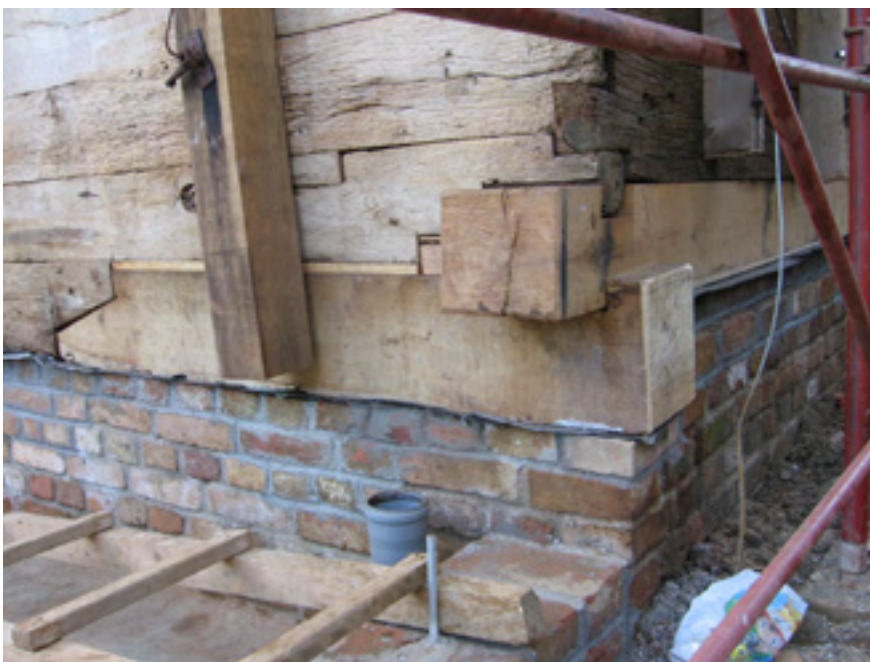
Zamjena trulih greda u podseku s podzidavanjem i hidroizolacijom nadtemelja
