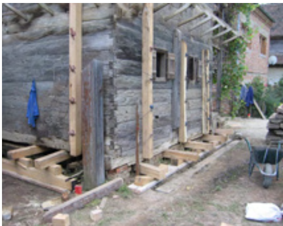
Sanacija temelja s niveliranjem kuće
