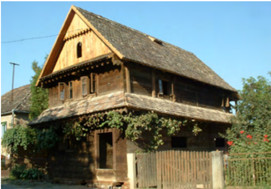
Obnova kuće u Krapju br. 30
