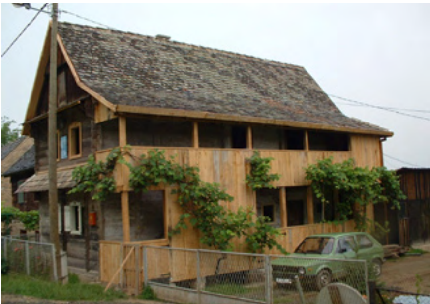
Obnova kuće u Krapju br. 164
