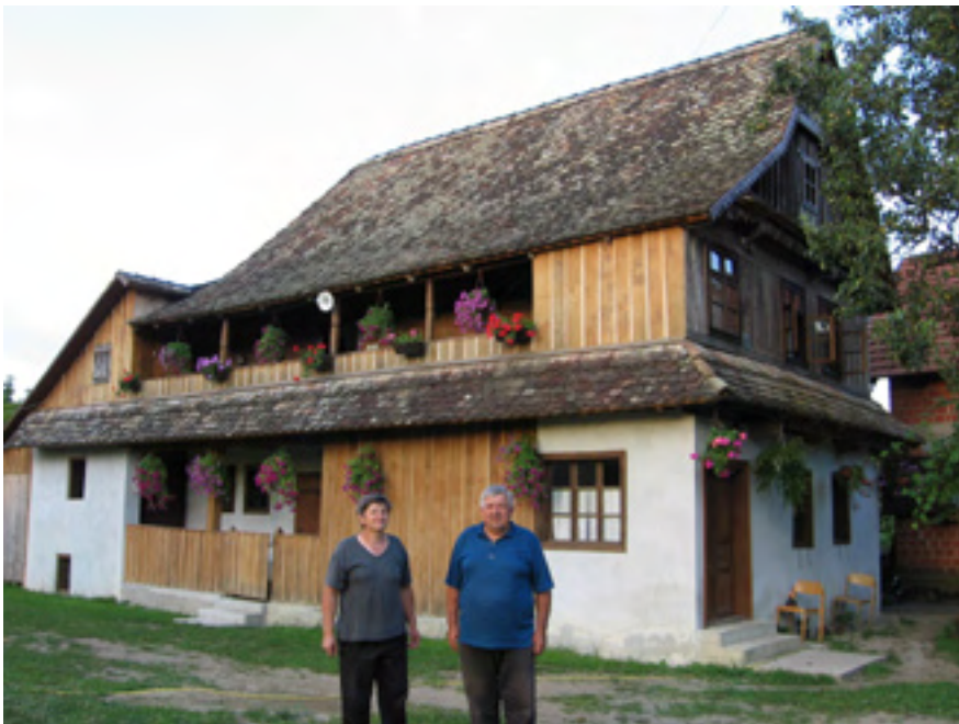
Obnova kuće u Lonji br. 1
