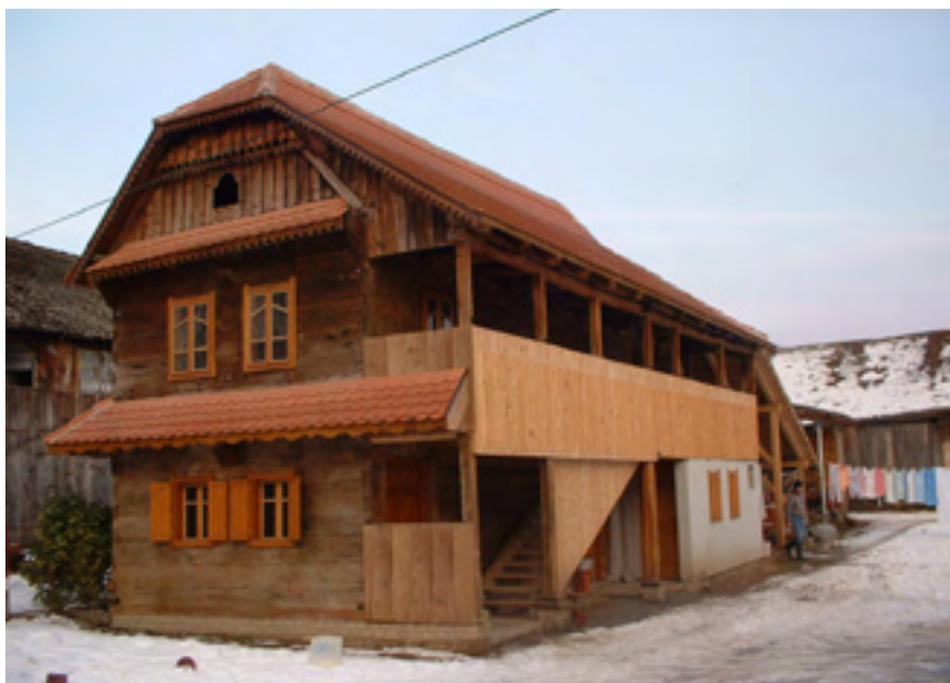
Obnova kuće u Čigoču br. 57
